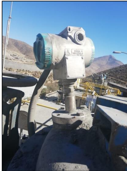
Figura N°3: Transmisor de presión instalado
